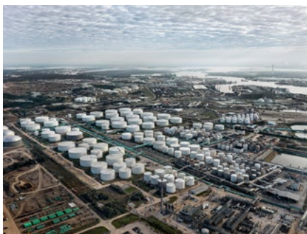
Entreposage de combustibles et de produits chimiques Houston, Texas, États-Unis, 2017
